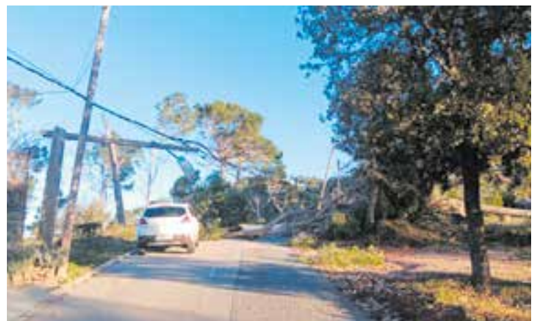
Carrer tallat a una de les urbanitzacions per pals elèctrics caiguts. || CEDIDA
