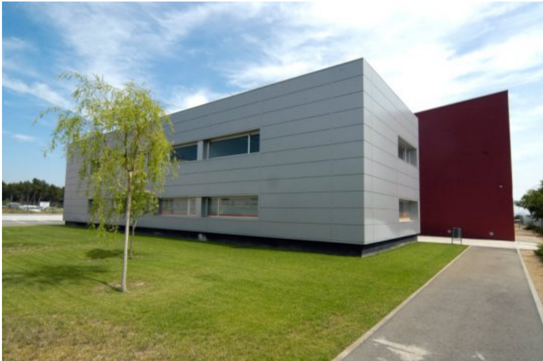
Centre de Serveis 1
