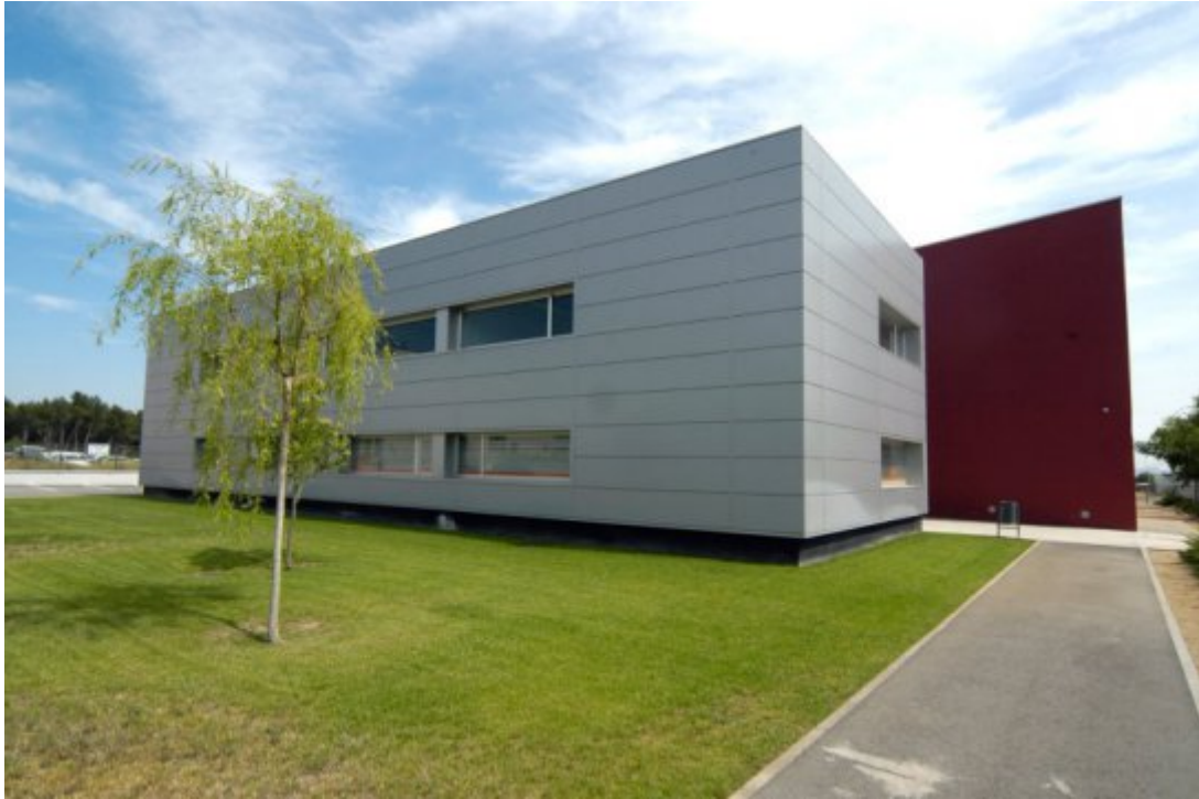
Centre de Serveis 1
