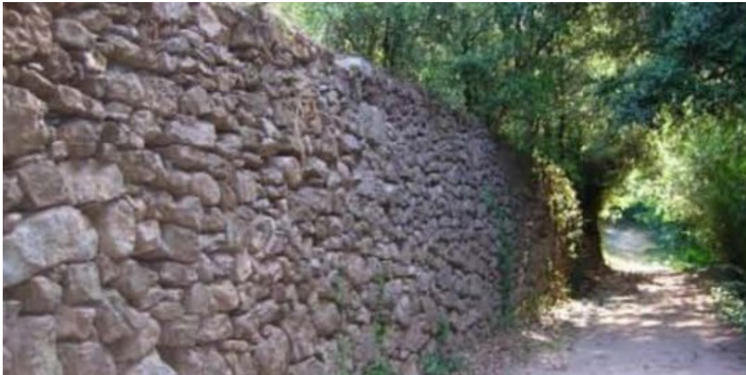
Construcció de pedra seca.
