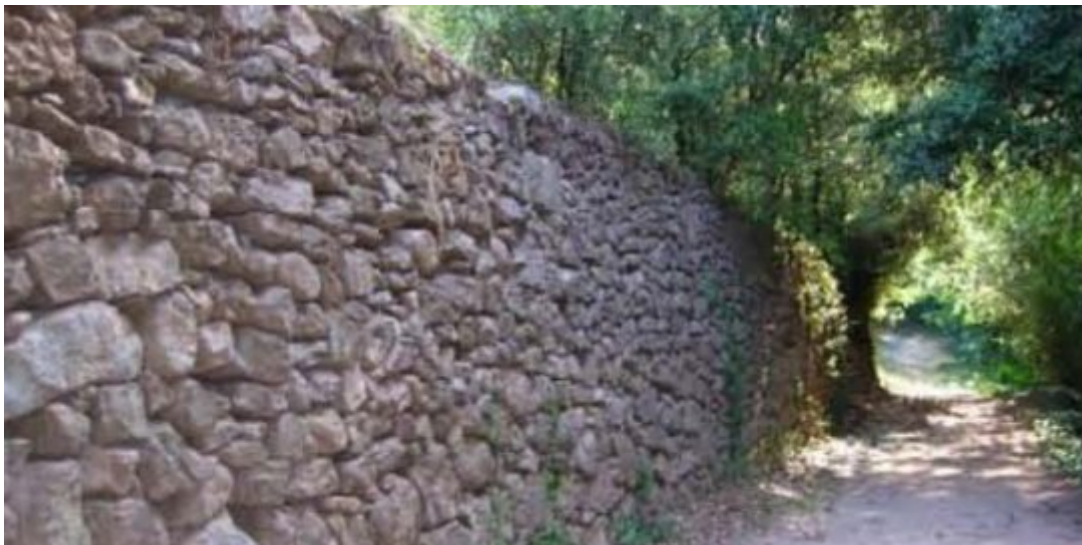
Construcció de pedra seca. Del 18 d'abril al 19 d'abril de 2018
