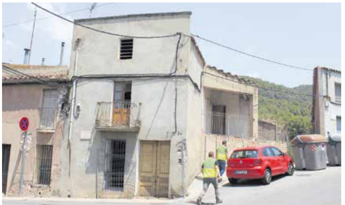
L'Ajuntament enderrocarà Cal Sesé, un immoble que es troba en mal estat al carrer de Canyelles. || AJ. CASTELLAR
