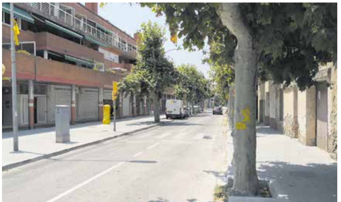
Ja s'estan finalitzant les obres d'ampliació de voreres de la carretera de Sentmenat. || AJ. CASTELLAR
