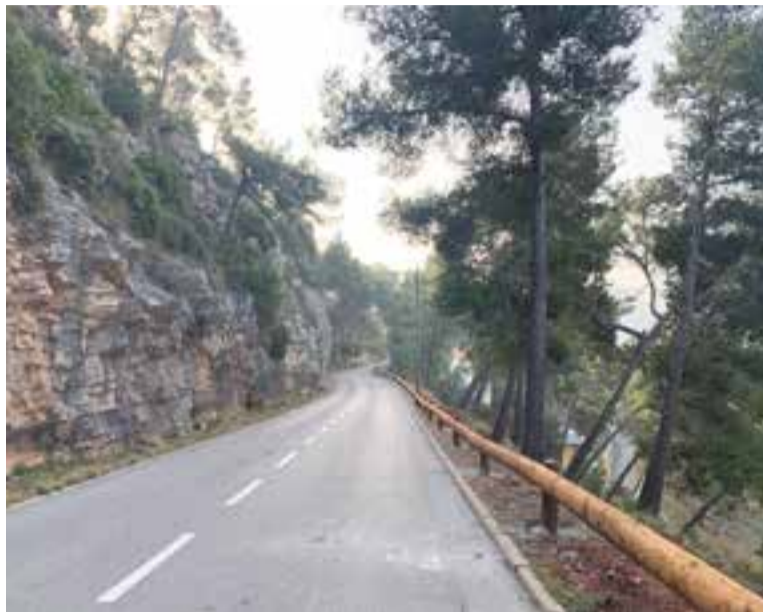
La barana que s'ha instal·lat en un tram en pendent del carrer del Cim. || AJUNTAMENT
