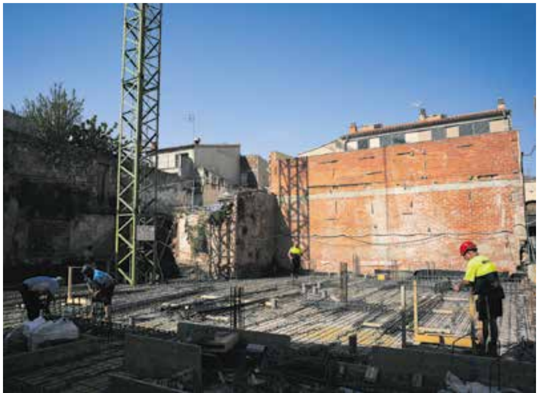
Operaris treballen al solar del carrer Retir on s'estan construint habitatges en aquests moments. || Q. PASCUAL
