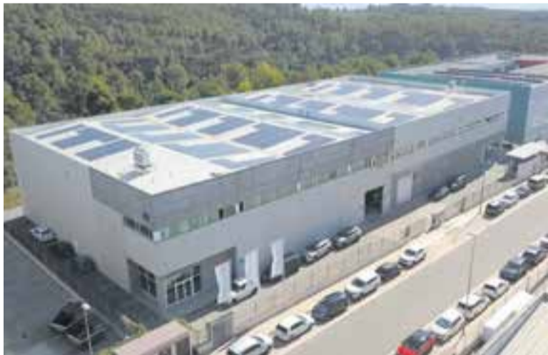
DigiProces ha instal·lat 478 panells fotovoltaïcs a la seva coberta. || CEDIDA
