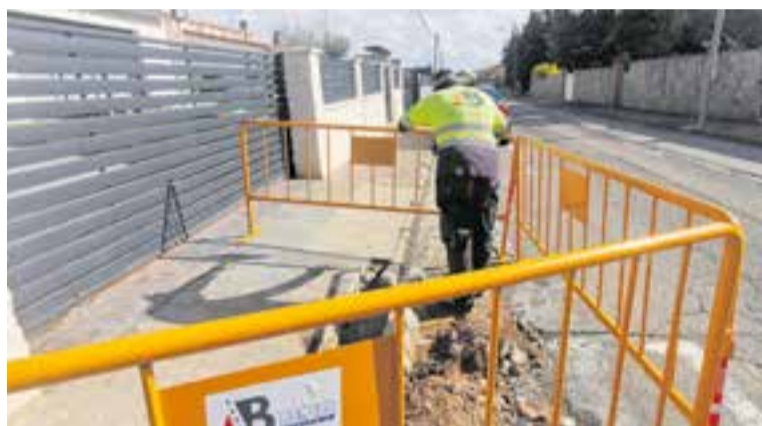
Feines d'asfaltat de reparació de voreres als carrers Sant Julià i Av. Can Font ||AJ.
