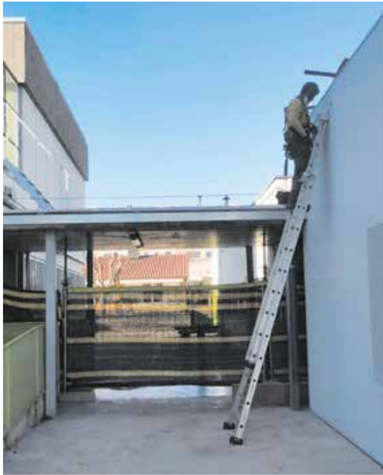
Un operari treballa en les obres actuals a l'IE Sant Esteve. || AJ. CASTELLAR
