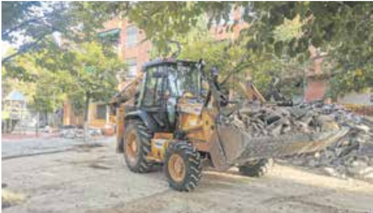
Els operaris ja han iniciat els treballs a la plaça del Forjador. || A. CASTELLAR
