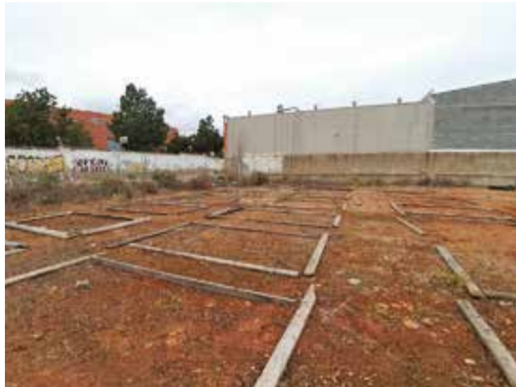
Primeres tasques de rehabilitació del solar || CEDIDA
