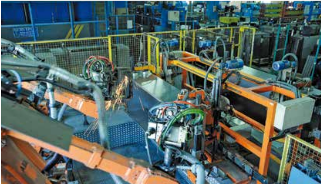
Interior de la nau que GAPSA té al carrer Conca de Barberà al polígon Pla de la Bruguera. || ARXIU
