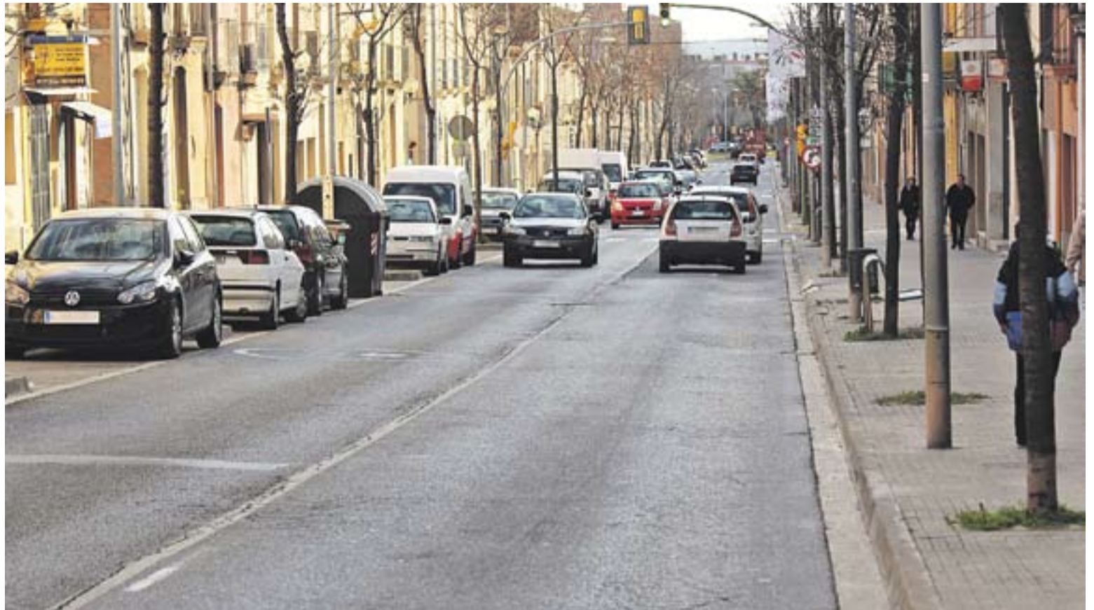
© El Passeig de Castellar serà un dels carrers on es faran obres de millora del paviment || Y. CALVO
