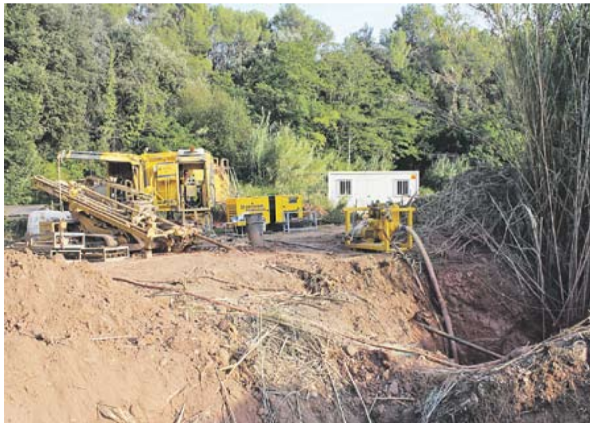
© Instal·lació d'una canonada especial que travessa el riu Ripoll per fer arribar el gas a Sant Feliu. || C. DOMENE
