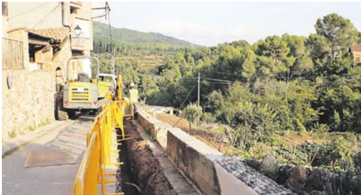
© Al carrer Mossèn Martí i Roca ja s'ha començat a fer una rasa per passar les canonades. || C. DOMENE
