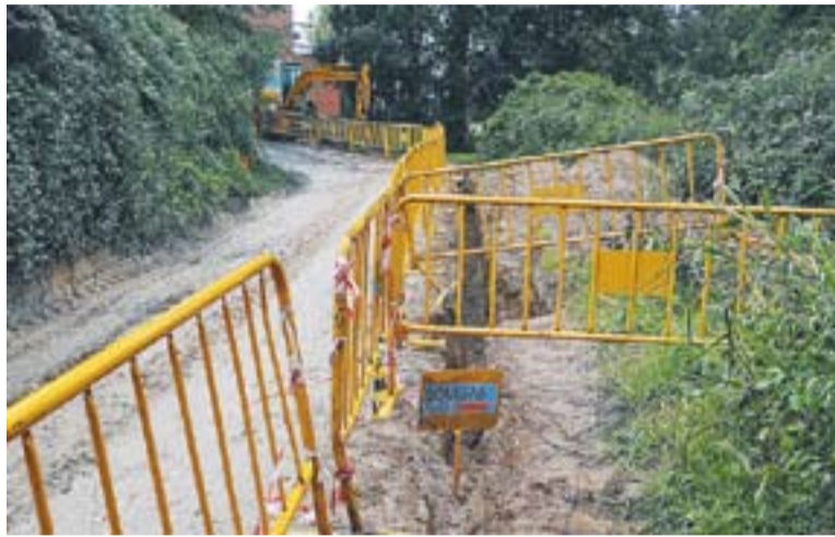
© Treballs de canalització a l'urbanització de Ca n'Avellaneda . || JOSEP GRAELLS
