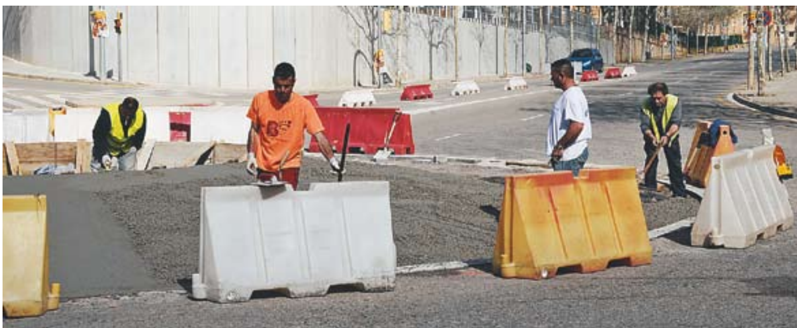
© Les rotondes s'estan construint a les cruïlles amb els carrers de Prat de la Riba, Països Baixos-Garrotxa, Barcelona-Solsonès, i Tarragona-Berguedà. || JOSEP GRAELLS
