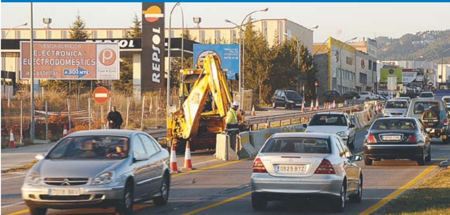
© El trànsit ja ha estat modificat perquè puguin començar les obres de la rotonda sense haver de tallar la carretera. || J.G.
