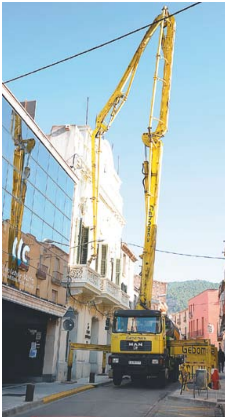
© La màquina bombejant formigó al segon pis de l'antic Ajuntament. || J.G.
