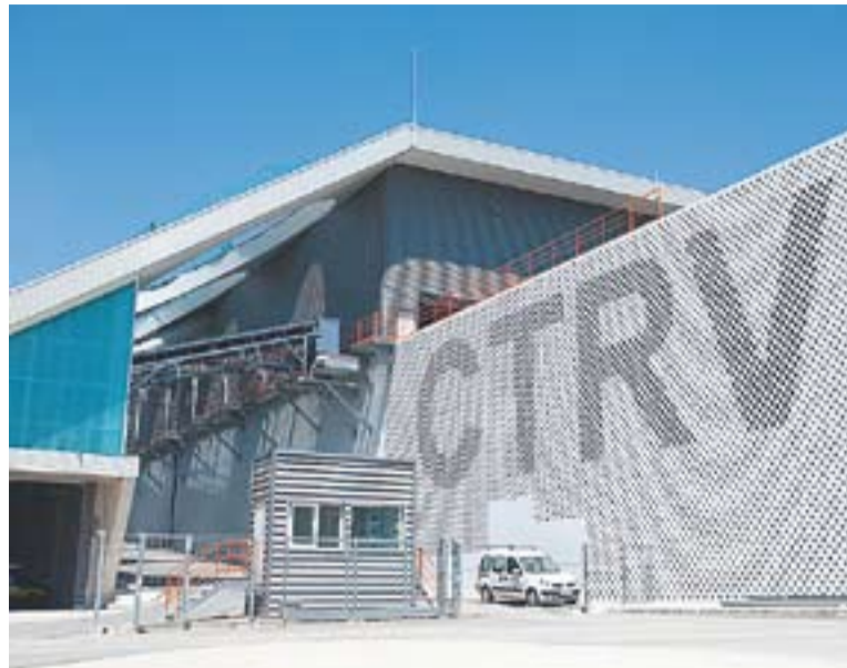
© Imatge recent de les noves instal·lacions. || CONSORCI PER A LA GESTIÓ DE RESIDUS
