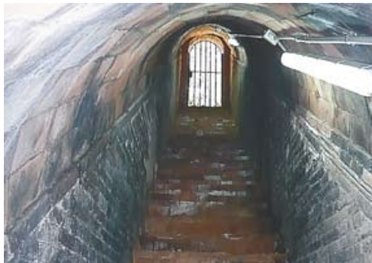
© Refugi antiaeri situat entre els carrers de Solsonès i de Bages. || ARXIU
