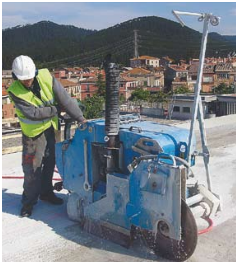
© La construcció ha estat un dels sectors clau en la reducció de l'atur. || J.G.
