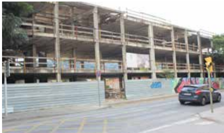
L'obra dels pisos de la B-124 que portava més d'una dècada aturada es reactiva. || J.C.
