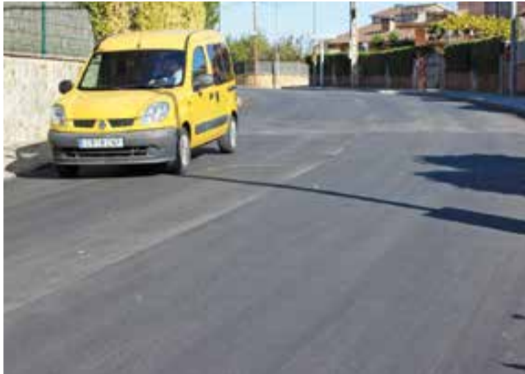
El carrer Santa Maria de Vilalba amb l'asfaltat renovat. || CEDIDA
