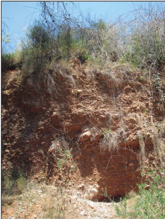
Fotografia 4: Límit Sud de l'àmbit
