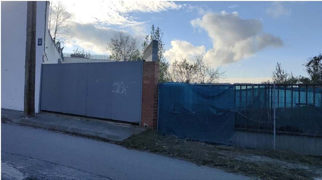
Porta d'accès a l'àmbit i construcció existent
